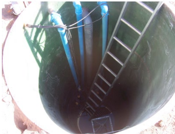
Fotografía referencial Planta Elevadora (Parte inferior se observa la rejilla)
